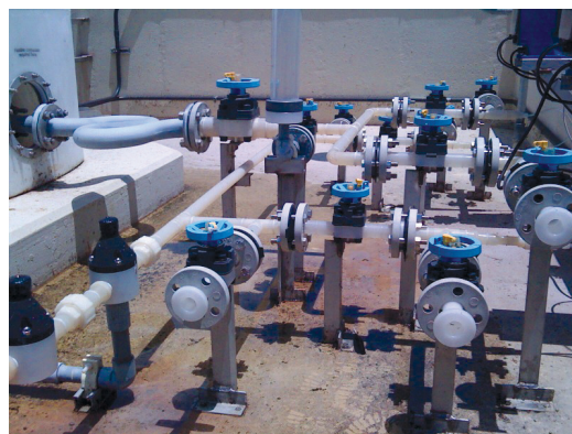
Sistema Ultra Proline® de Asahi/America para ácido sulfúrico con válvulas de diafragma T342.
